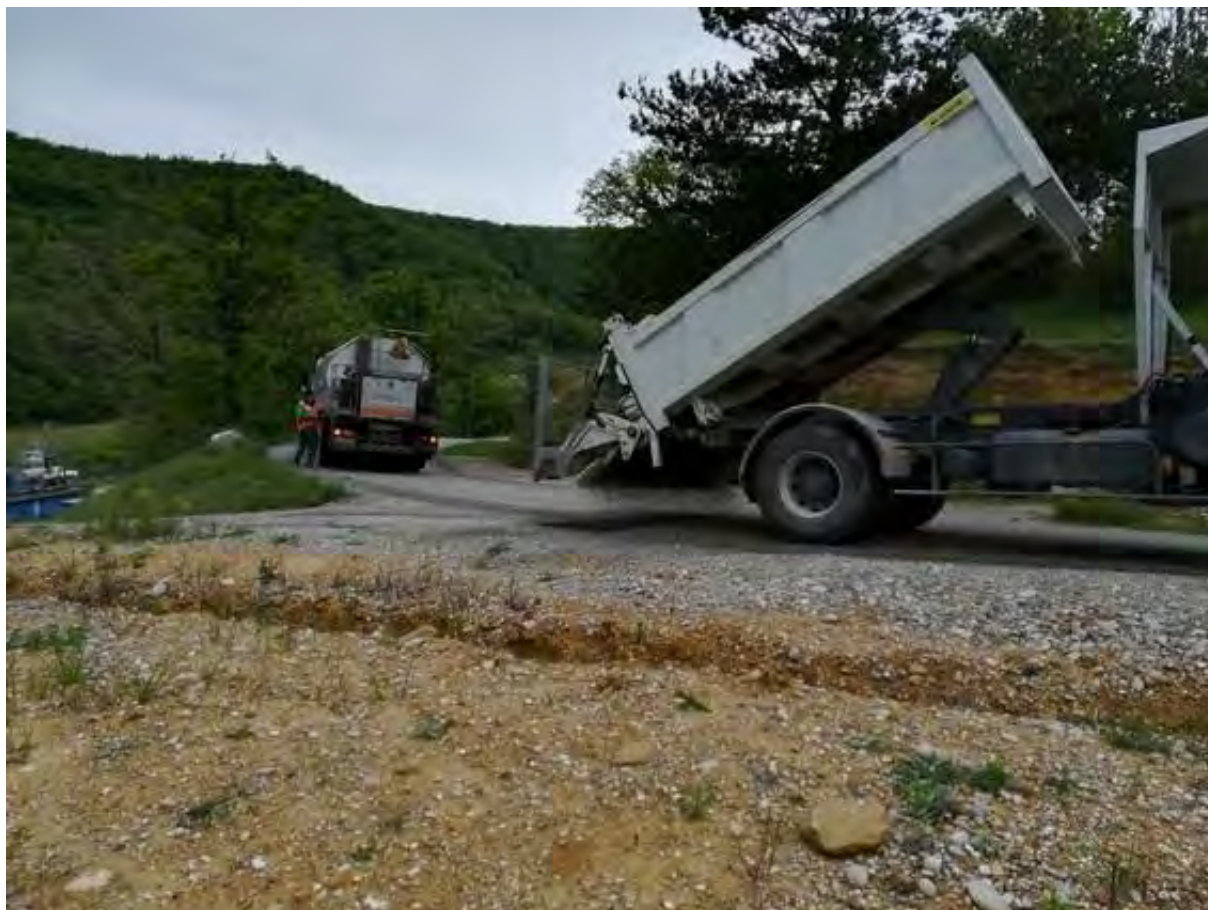
Photo 6 : Pose du revêtement.
